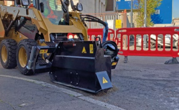
T 300. Schaffung des Mikrograbens mit einer 25 mm breiten Scheibe.
