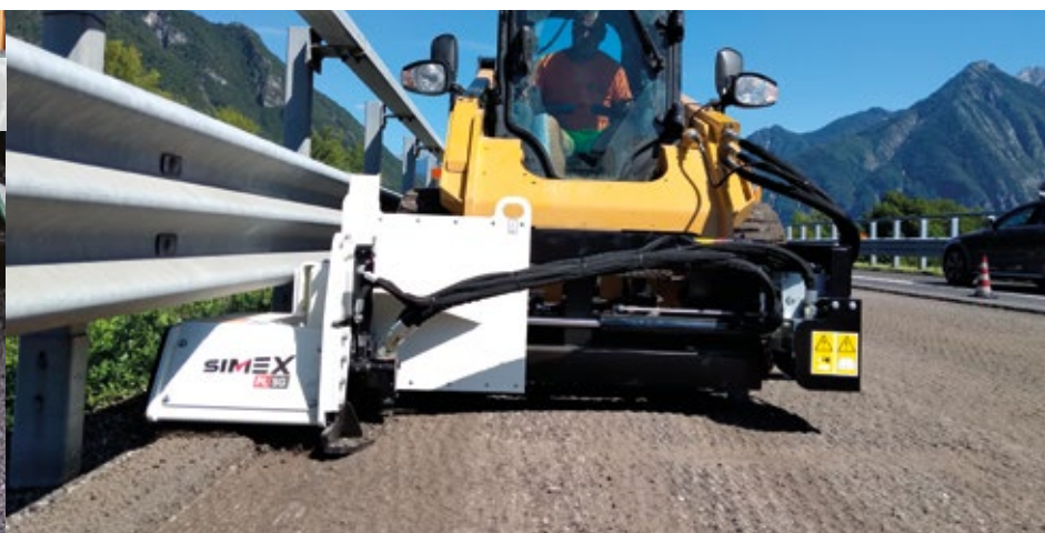
Förderband der PL SG, das Fräsgut zur Seite abwirft
